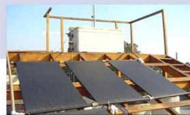
Figura 1: Protótipo de aquecedor solar de baixo custo (2,2 m<sup>2</sup>).
